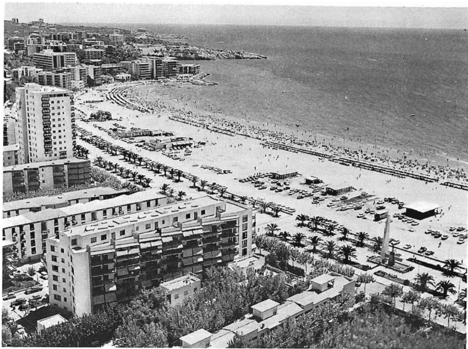
91. El cap de Salou ha estat pràcticament engolit per un recobriment quasi continu d'edificacions. [Foto (1974) de T.A.F.]
