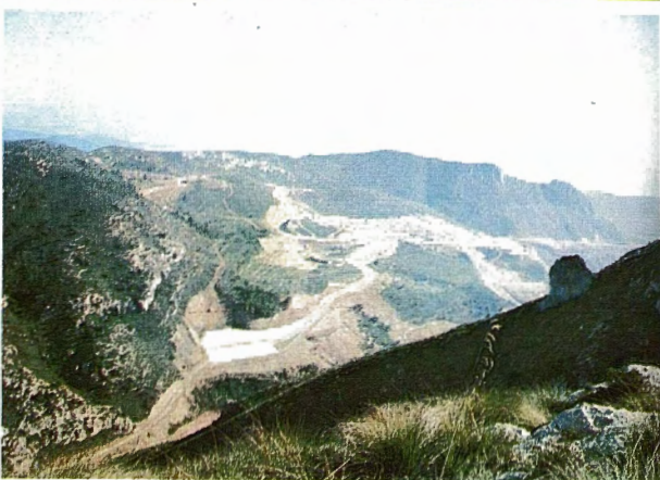
215. La Vall de Joan (Garraf) tot just iniciades les obres de construcció de l'abocador d'escombraries, i amb l'abocador en plena construcció.
