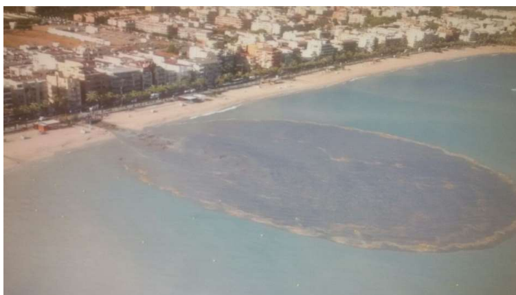
FIGURA 15. Sortida al mar del barranc de Barenys, a Salou. Abocament d'aigües pluvials i sobreiximents de sistemes de col·lectors amb aigües residuals barrejades per la impossibilitat d'engolir la totalitat de l'aigua recollida després d'un episodi de pluja.
