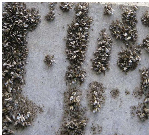
FIGURA 4a. Exemplars de musclo zebra ( Dreissena polymorpha ) presents a la paret de la presa de la Baells. Aquesta espècie es troba actualment a la Baells (Llobregat) i al tram del riu Ebre a Catalunya, especialment als embassaments de Riba-roja i de Mequinensa.
